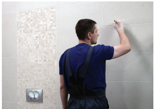
Dodatkowe zabezpieczenie powierzchni fugi jak i okładziny przy użyciu silikonowego impregnatu CT 10
