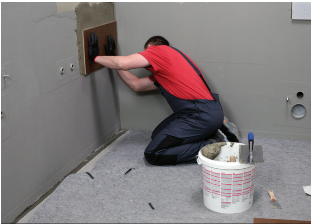
W przypadku powierzchni pionowych nie wymagane jest stosowanie np. listew startowych z uwagi na brak spływu
