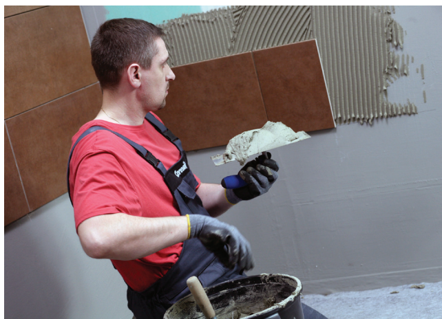
Prawidłowo dobrana konsystencja zapewni odpowiednią przyczepność zarówno do narzędzi jak i do podłoża
